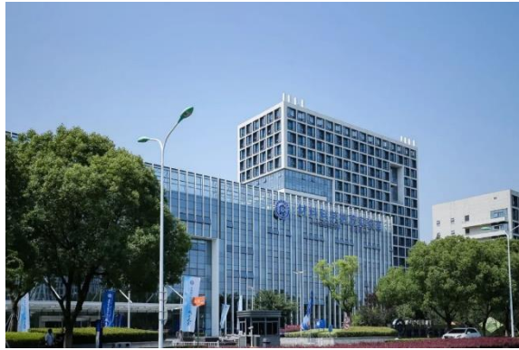
姑苏实验室规划总投资200亿元，总部位于苏州工业园区，占地500亩
