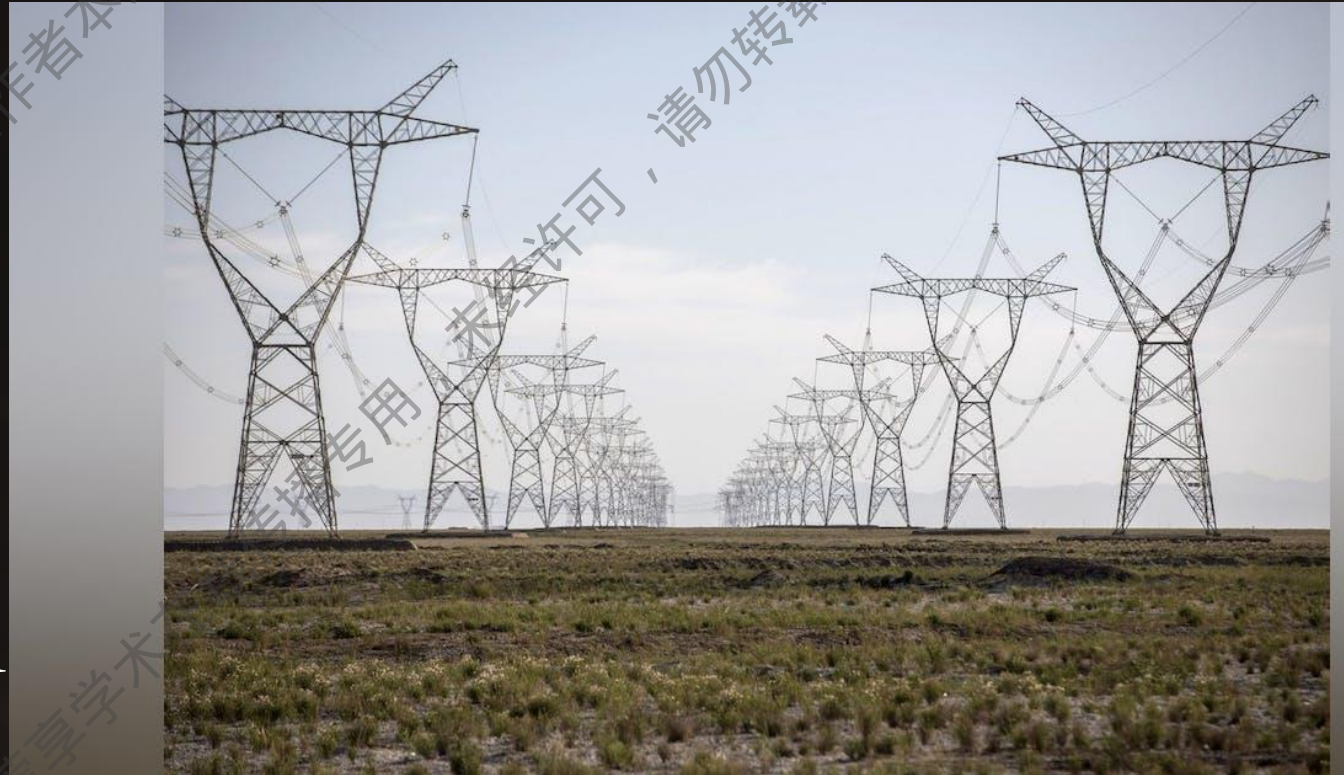
中国标准的超高压输电,1100千伏
